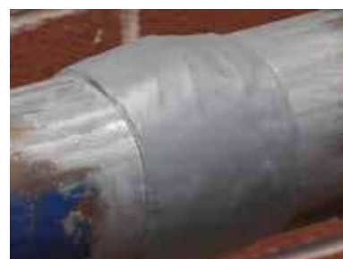
Oprava netesnosti dokončená
