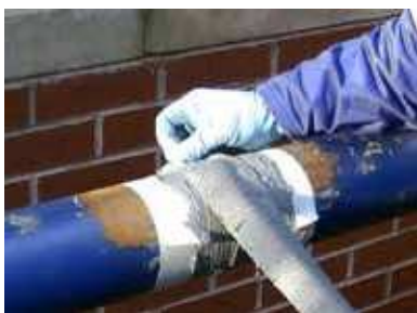
Výstužná tkanina Belzona 9341 použitá na opravu obalením
