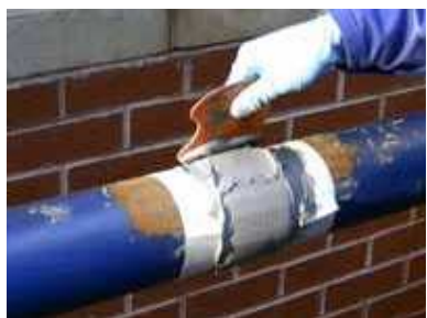
Nanesená vrstva produktu Belzona 1212
