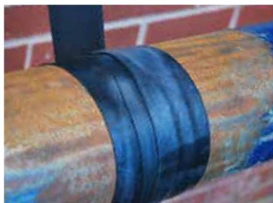
Belzona 9611 a škrtdlo
